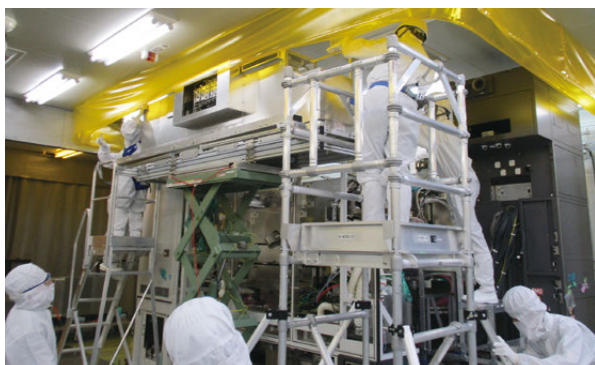
装置の設置作業
